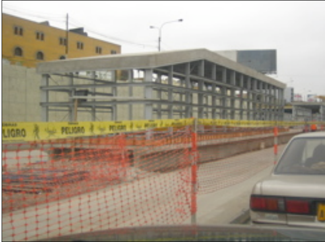
Una nueva estación del Metropolitano bajo construcción en Lima (foto por AEI)
